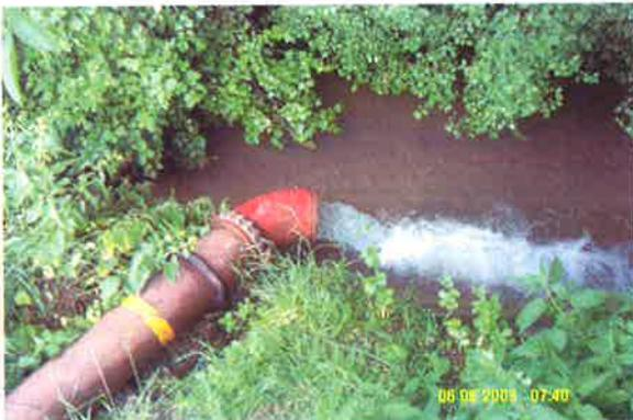
Abb. 8: Wasserhaltung BV Bahnunterführung
